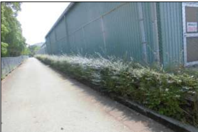
(C)室内練習場周辺 ⑤ 室内練習場南通路沿い
