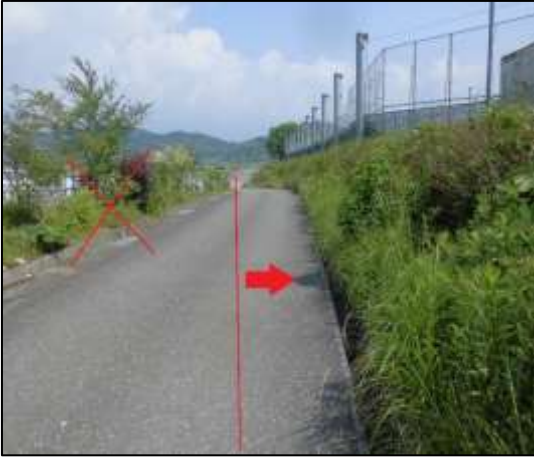
(D) 東法面 ⑦ 東法面
