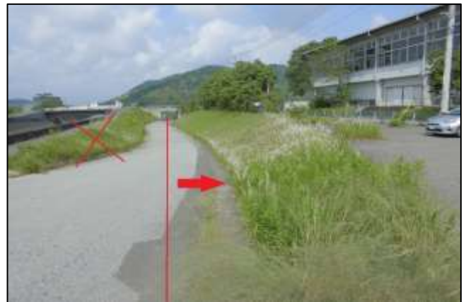
(D)東法面 ⑥ 体育センター北法面
